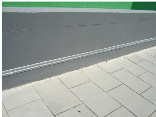
Remate da impermeabilização contra um paramento com uma altura correcta. O perfil de remate está bem instalado e selado na parte superior.
