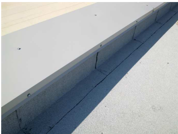
Cumeeira metálica num paramento baixo de uma cobertura em consola.
