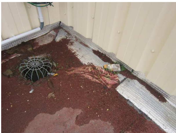
Nas visitas de inspecção deve-se rever qualquer detrito que possa existir na cobertura e proceder à sua remoção.
