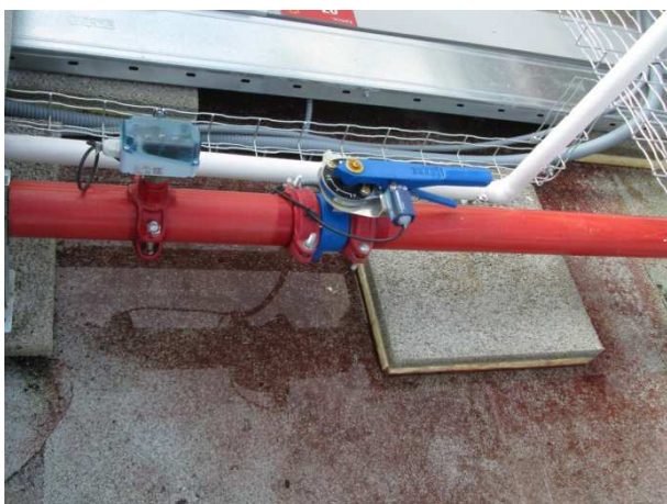
Elemento de apoio de condutas, retendo a evacuação das águas.
