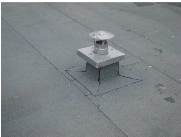
Passagem de condutas de ventilação mediante passa-tubos.
