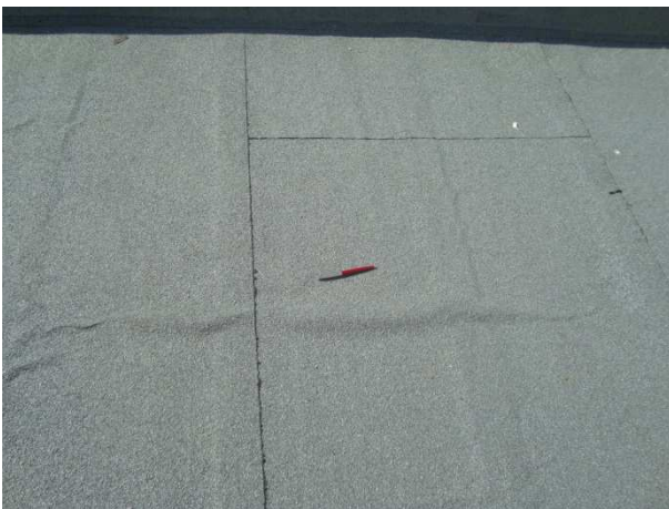
Rugas perpendiculares ao sentido longitudinal do rolo.
